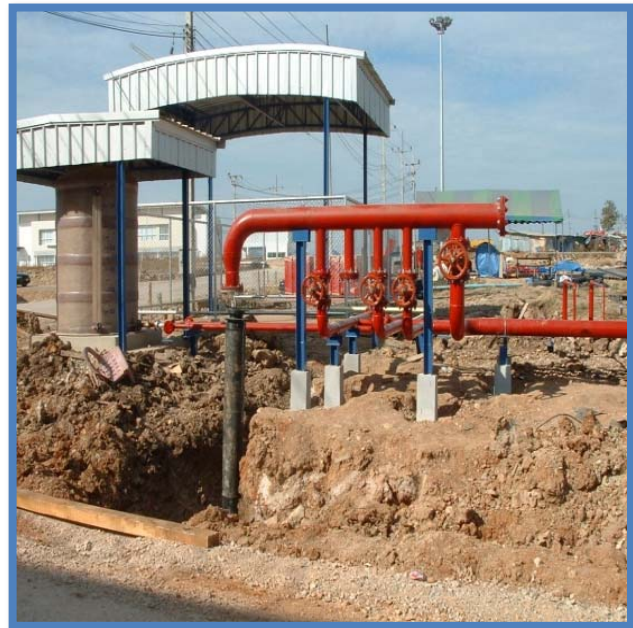
งานติดตั้งระบบ FOAM โรงงาน เอทานอล บจก.แม่สอดพลังงานสะอาด จ.ตากปี2551
