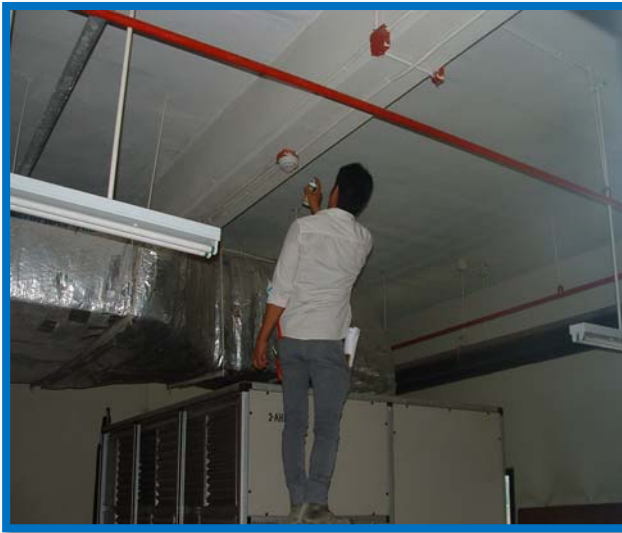
งานติดตั้งทดสอบปรับปรุง ระบบ Fire Alarm มหาวิทยาลัยสุโขทัยธรรมาราช ปี 2556
