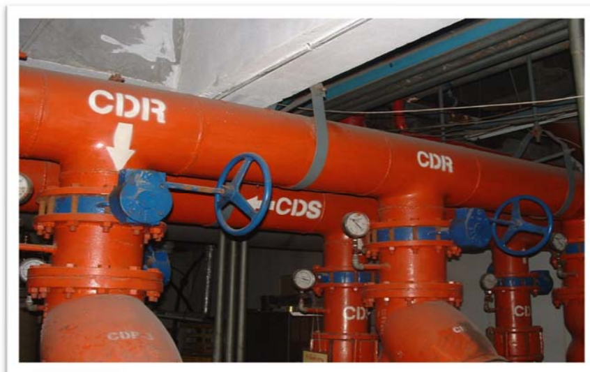
งานเปลี่ยนท่อ และวาล์วระบบ Chiller โรงแรมลายทอง จ.อุบลราชธานี ปี 2551
