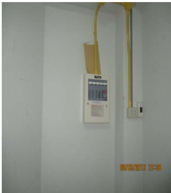
งานติดตั้งFire Alarm System กฟผ.แห่งประเทศไทย(Egcat)โรงงานบางปะกง 2 อาคาร ปี2559
