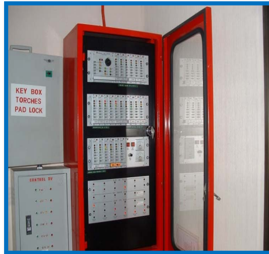
งานติดตั้งระบบ CO2 และ FIRE ALARM ADIYA BERA GROUP จ. สระบุรี ปี 2551
