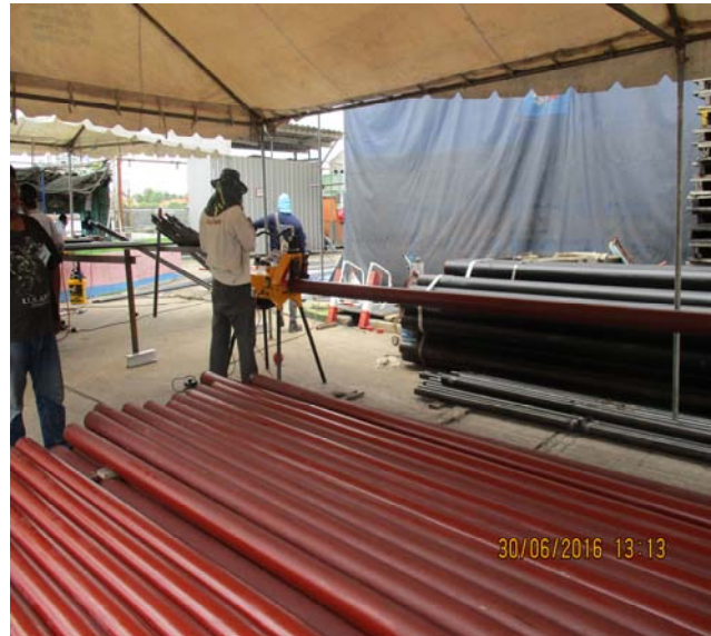
ติดตั้งโดยระบบเครื่อง Grooving
