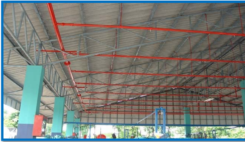
งานติดตั้งระบบ SPRIKLER SYSTEM ปตท.ปี 2552
