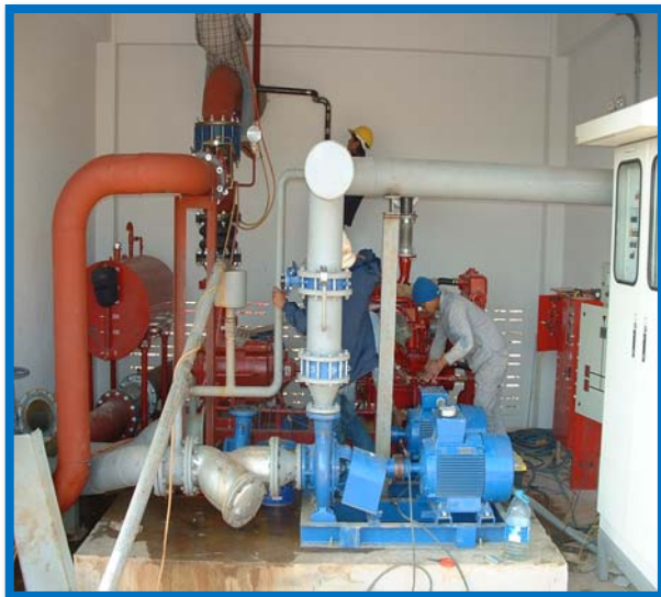
งานติดตั้ง FIREPUMP และ ตู้ FHC โรงงานแม่สอดพลังงานสะอาด จ.ตากปี2551
