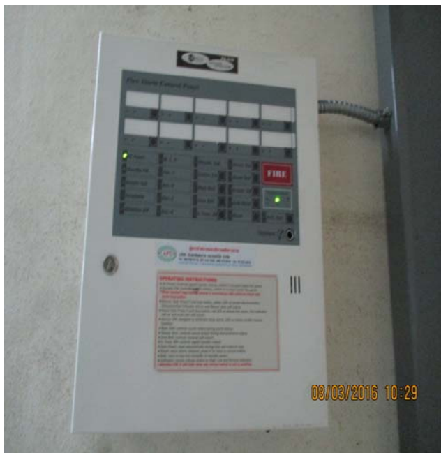
งานติดตั้งFire Alarm System กฟผ.แห่งประเทศไทย(Egcat)โรงงานบางปะกง 2 อาคาร ปี2559
