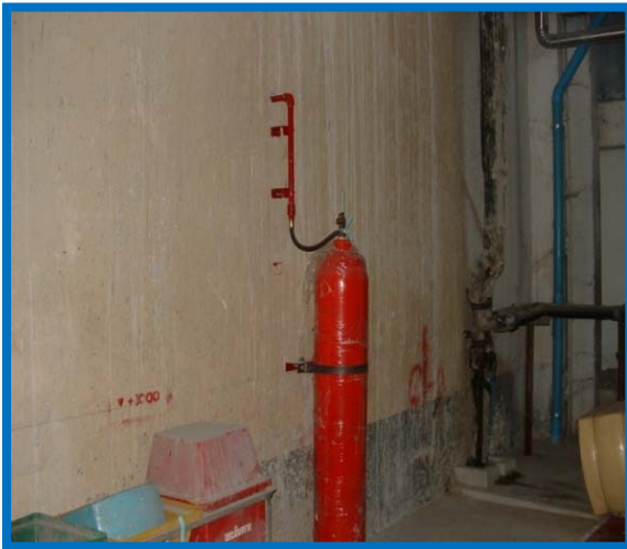
งานติดตั้งระบบ CO2 และ FIRE ALARM ADIYA BERA GROUP จ. สระบุรี ปี 2551
